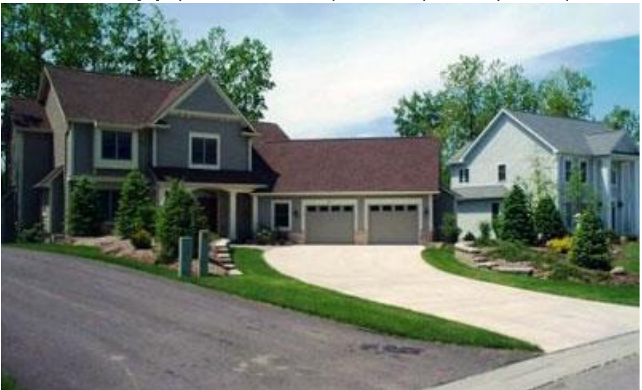
תמונה 2 - דרך גישה מבטון בהיר בעל מקדם החזר גבוה וקיבולת חום נמוכה במיוחד. מקור: [48]
